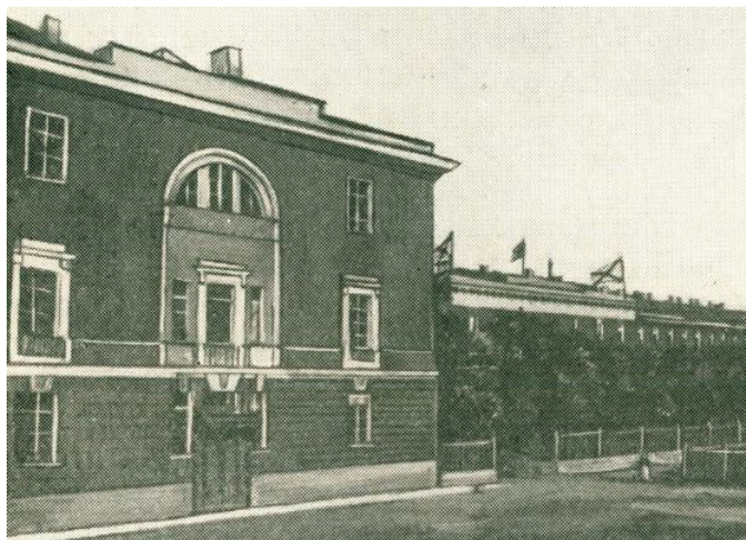
Рис. 2. Здание Кронштадтского госпиталя
